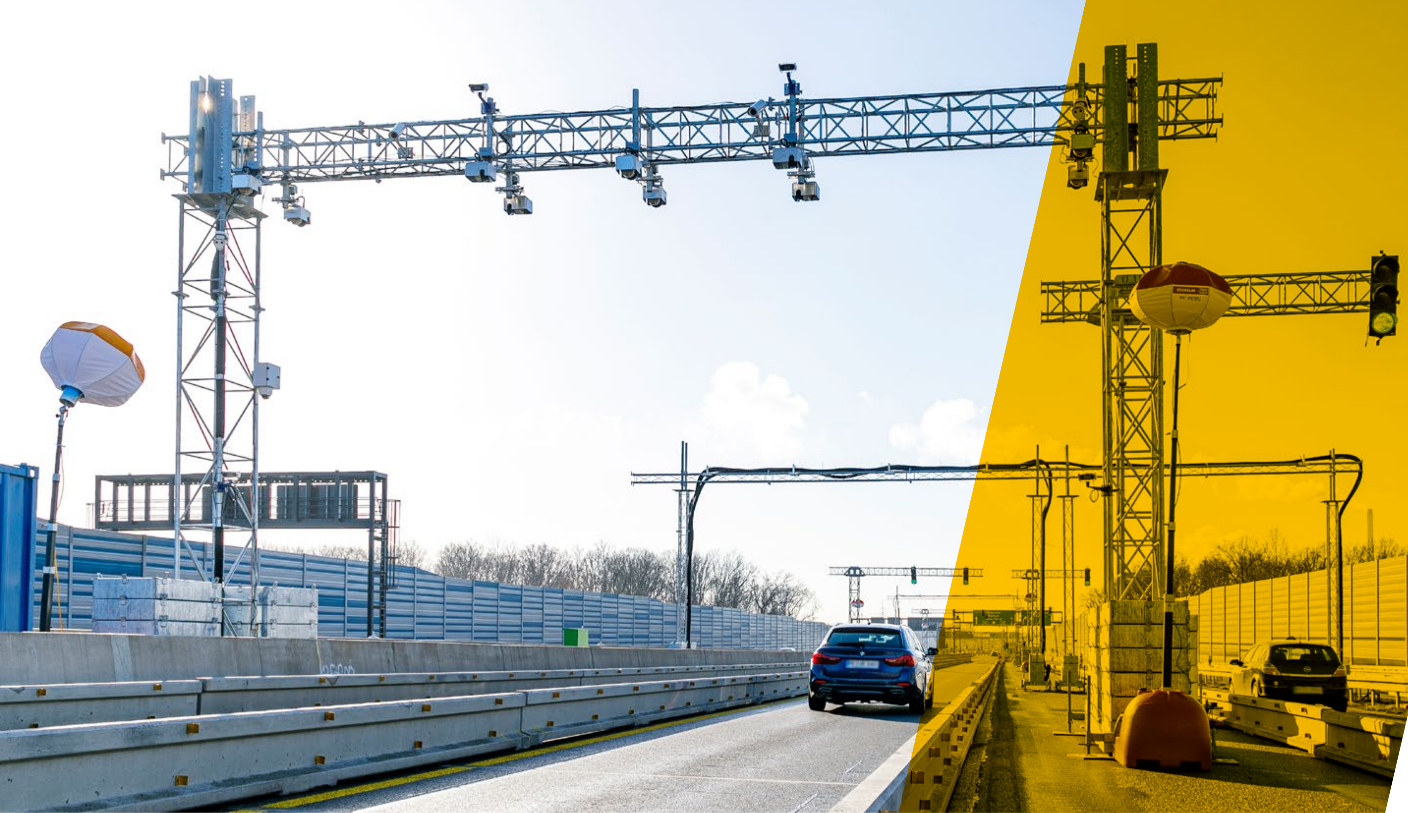
An Trägerbrücken wurden Überwachungskameras und ANPR-Kameras befestigt.
