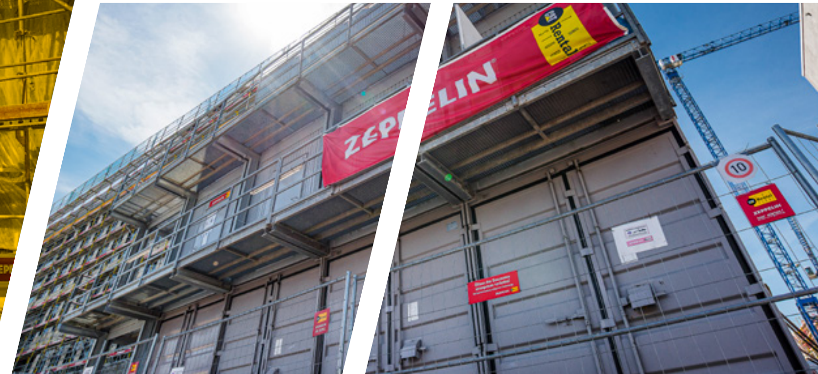
Vom Baustrom bis zum Bürocontainer: Auch die temporäre Infrastruktur gehört zum Portfolio.
