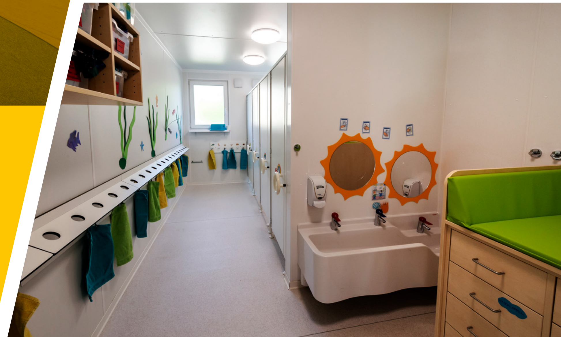
Im Sanitärbereich sind unterschiedlich hohe Waschplätze, Toiletten sowie eine Duschwanne verbaut
