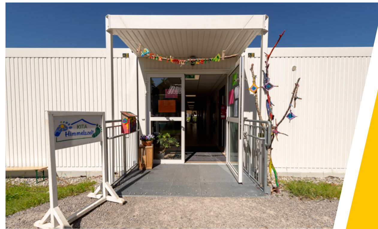
In nur vier Wochen wurde die Anlage inkl. Eingangspodeste und Vordächer fertiggestellt
