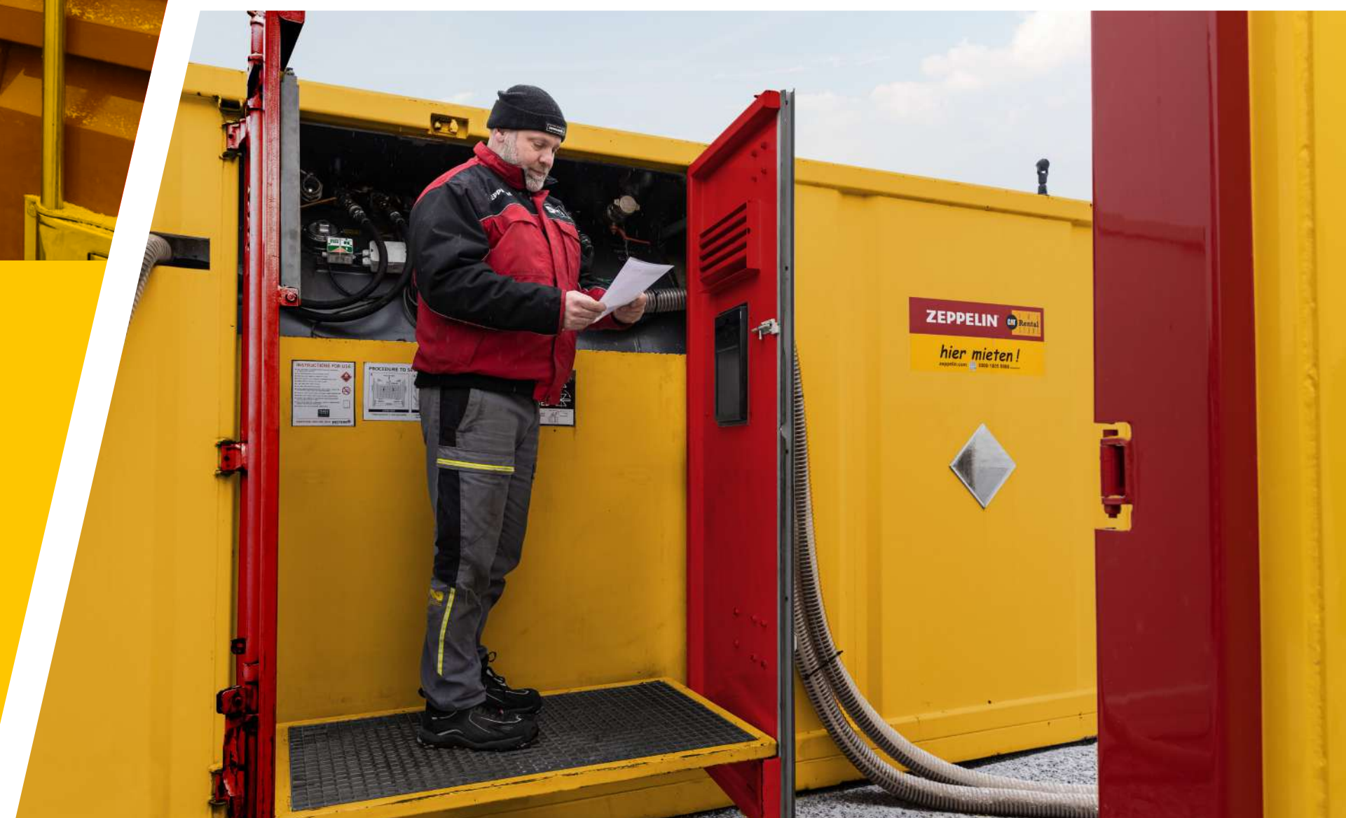
Aufgrund der niedrigen Temperaturen wurden die zwei Tank-Container mit Diesel anstatt Heizöl gefüllt. 20.000 Liter fasst ein Exemplar
