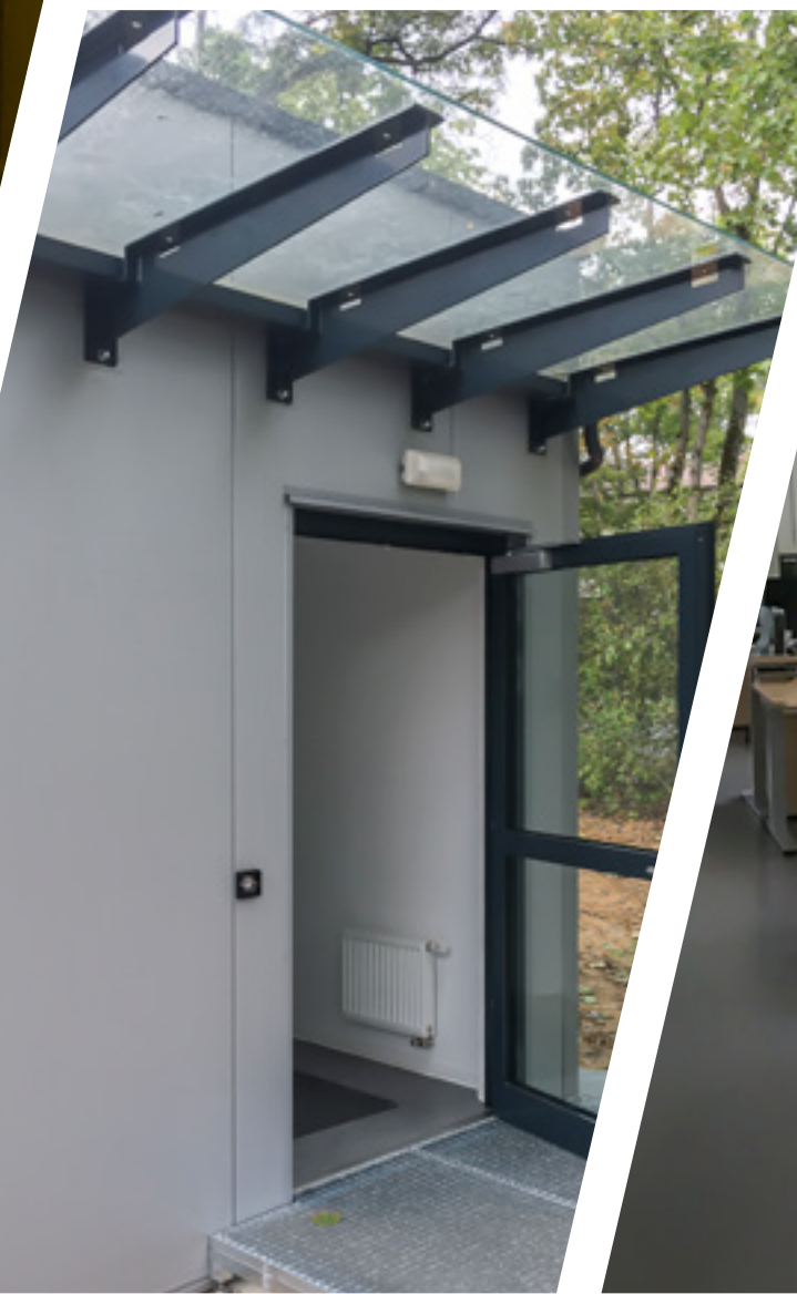
Eingangstür mit Glasvordach
