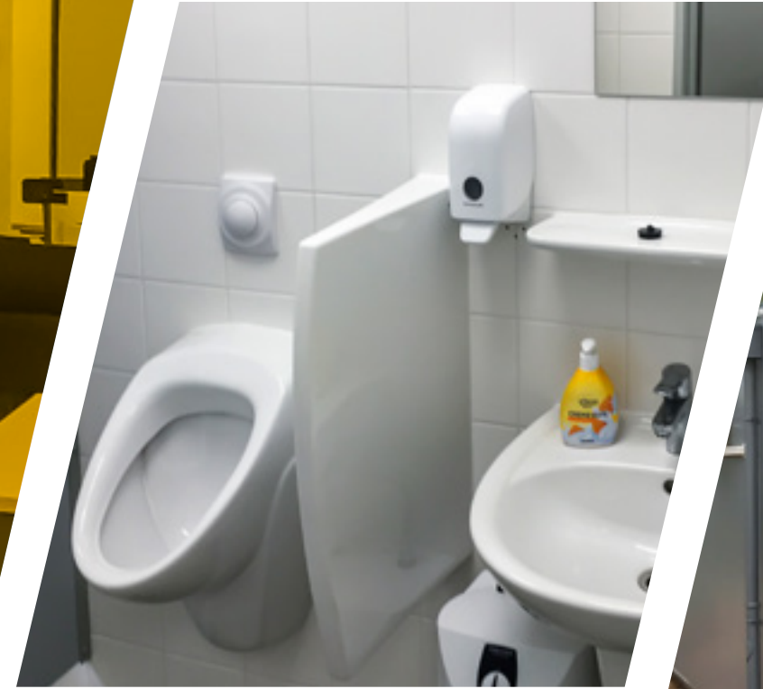
Einer der Sanitärbereiche
