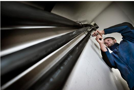
Alle Leitungen und Kabel werden durch den leeren Aufzugschacht in die einzelnen Etagen geführt.
