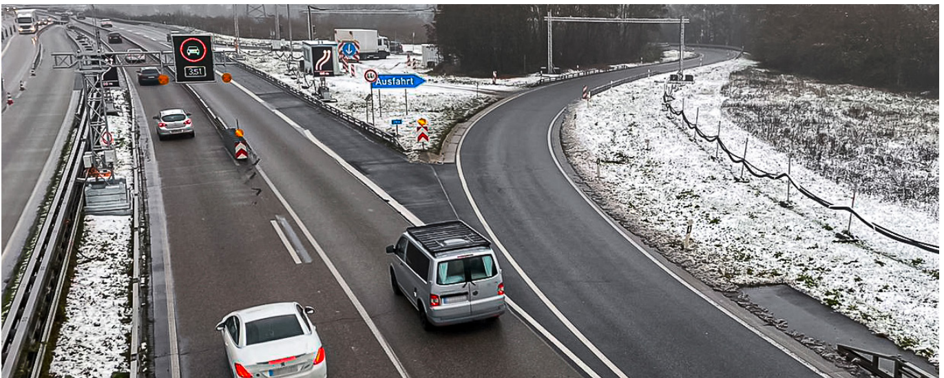
Fernbedienbare Wechselverkehrsführung zur Vermeidung von Stau (Bildquelle: Zeppelin Rental)
