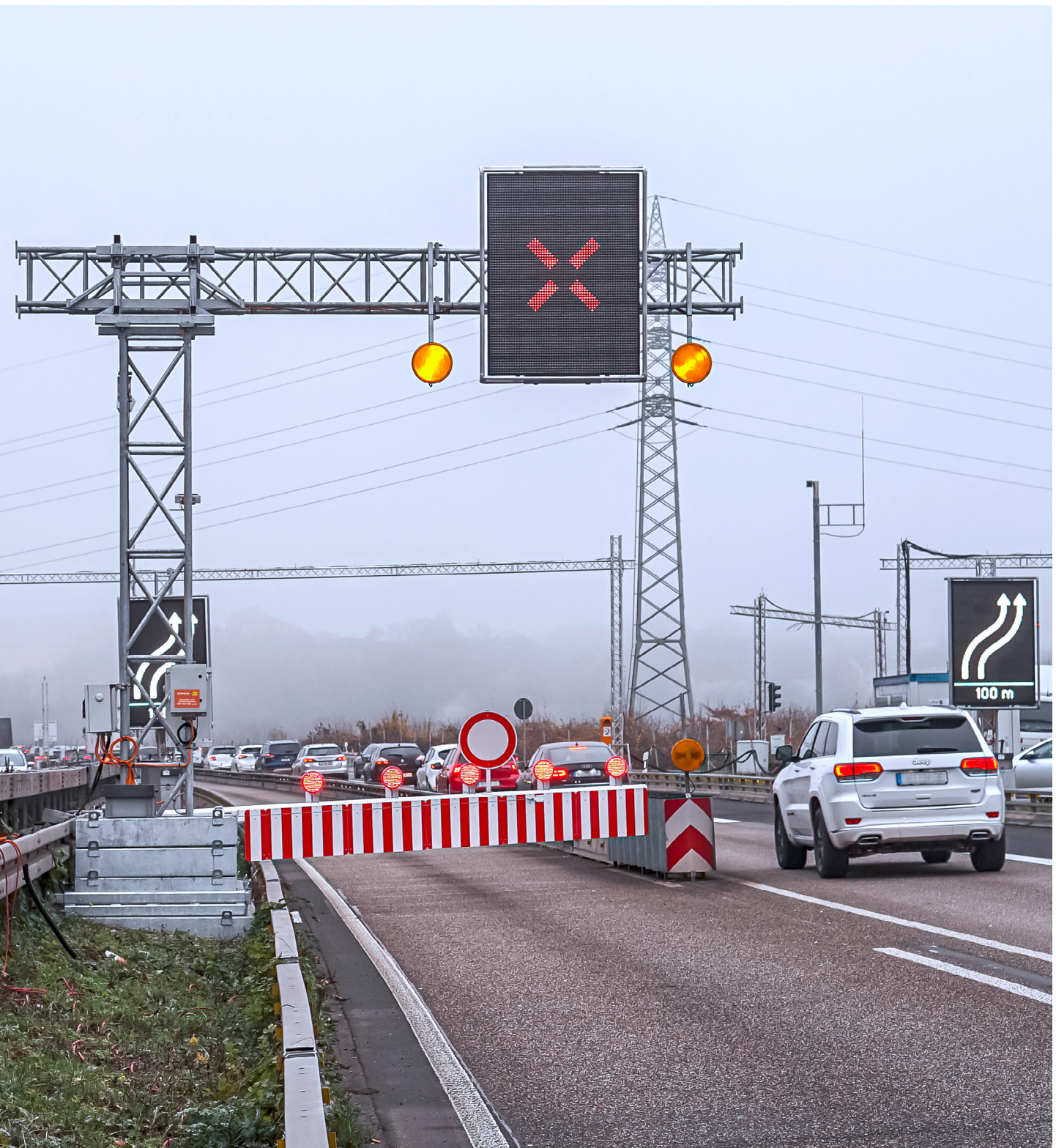
Zeppelin Rental richtete die Verkehrsführung auf dem Nordbauwerk der Salzachtalbrücke als fernbedienbare Wechselverkehrsführung ein (Bildquelle: Zeppelin Rental)
