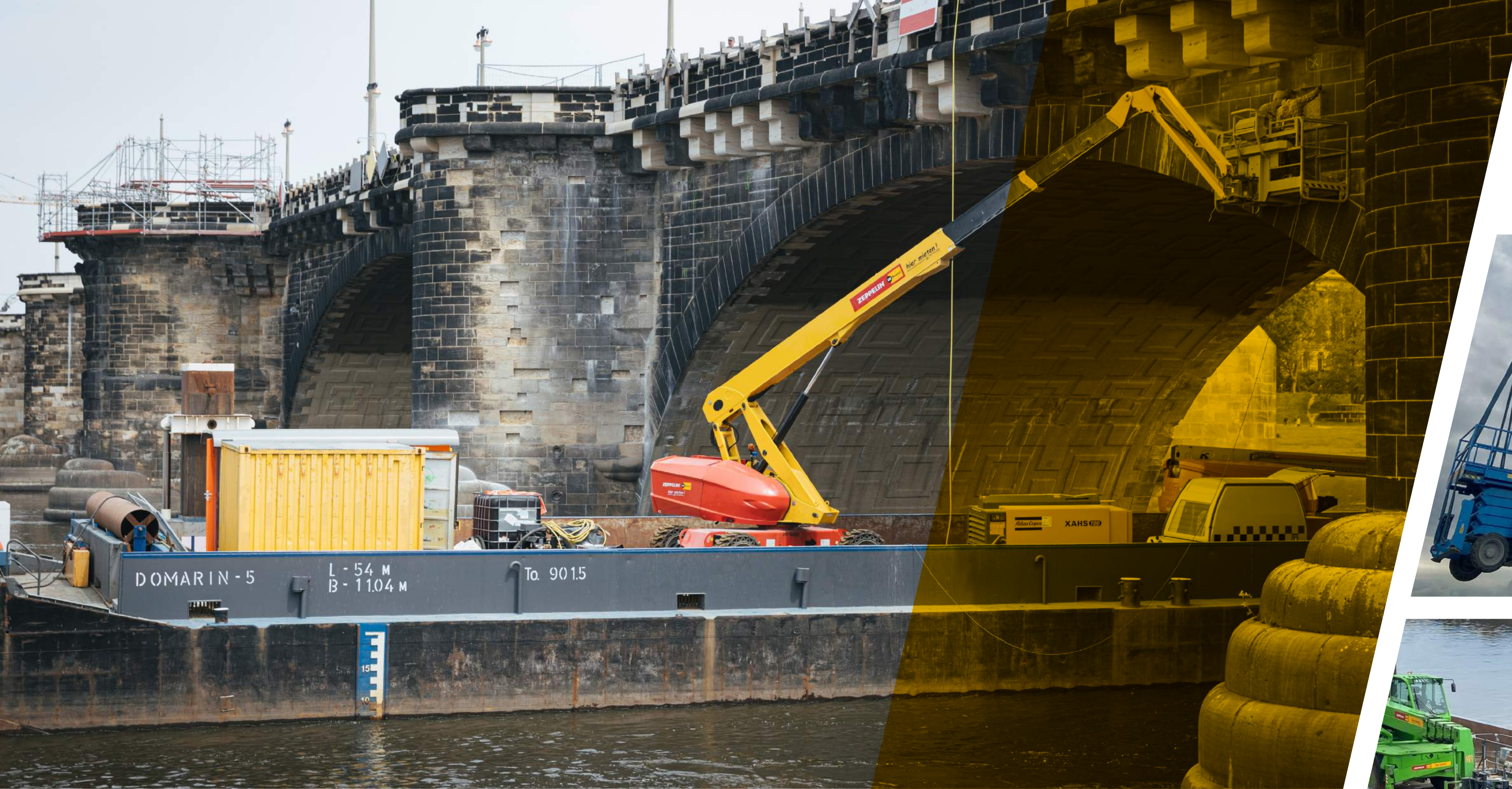
Präzisionsarbeit: Kaputte Sandsteine wurden nummeriert, repariert und dann an der gleichen Stelle wieder eingesetzt.
