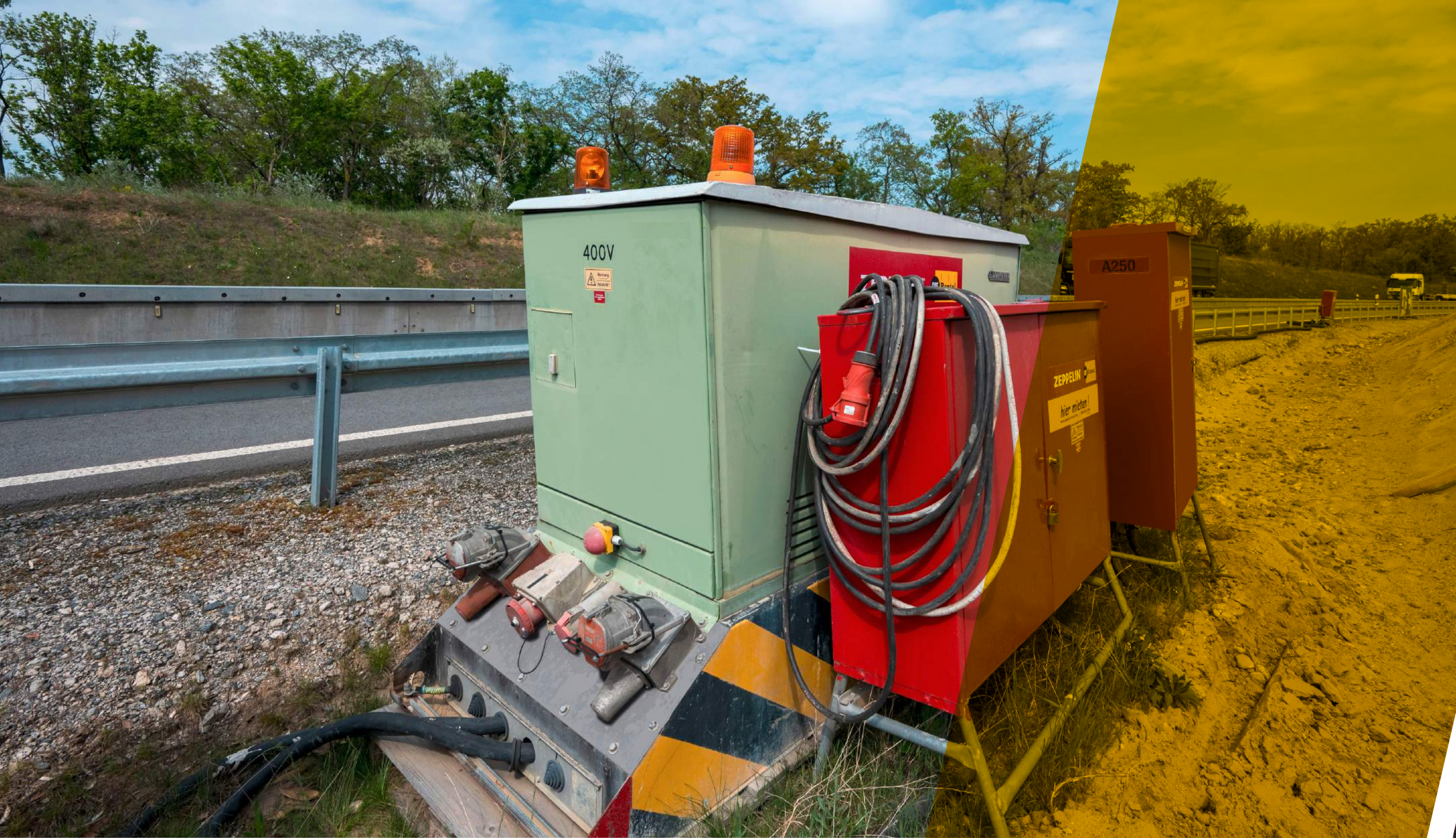
Direkt neben der Autobahn befindet sich ein „Abwärtstrafo“, der die Stromverteiler mit dem geeigneten Nutzstrom (400 Volt) versorgt
