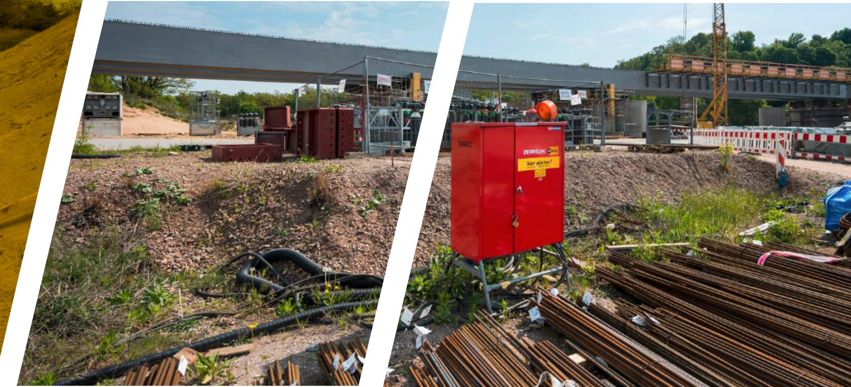
Die ausführende Gewerke benötigen Strom, um Bewehrungsstahl zu schweißen
