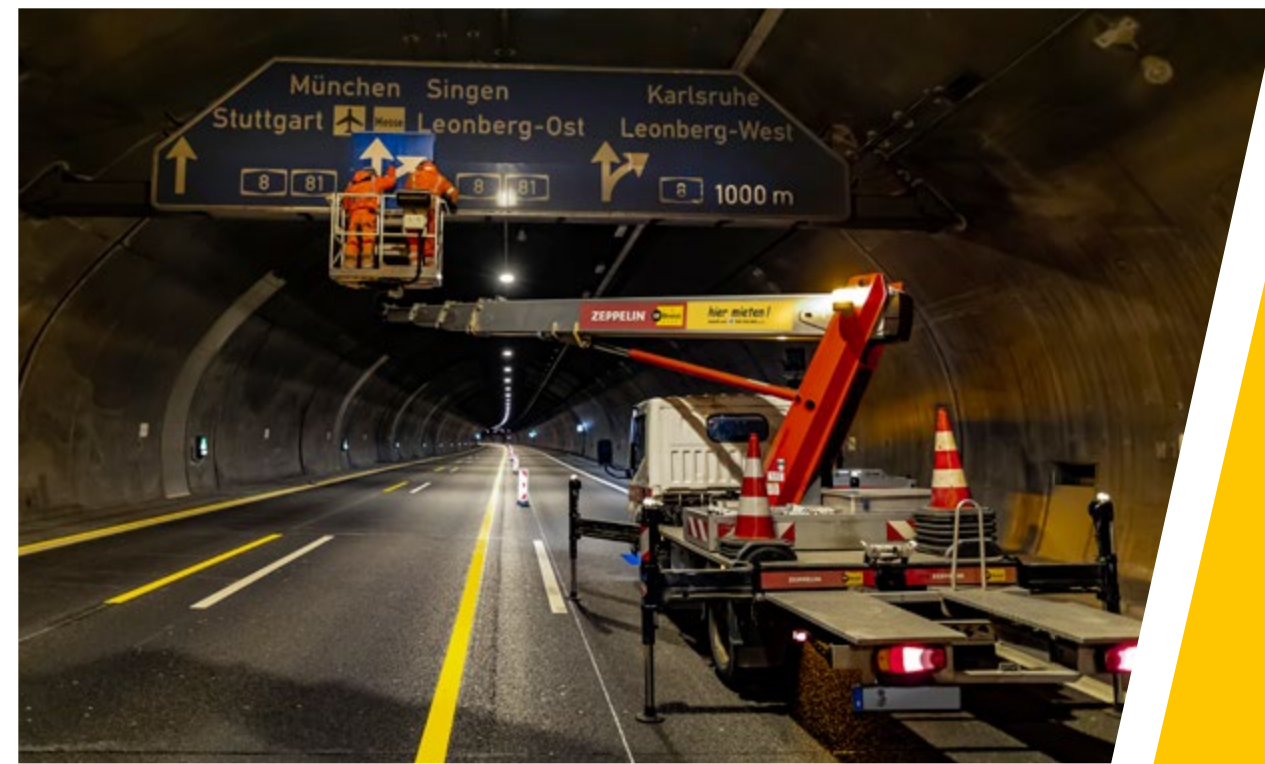
Anpassung der stationären Tunnelbeschilderung
