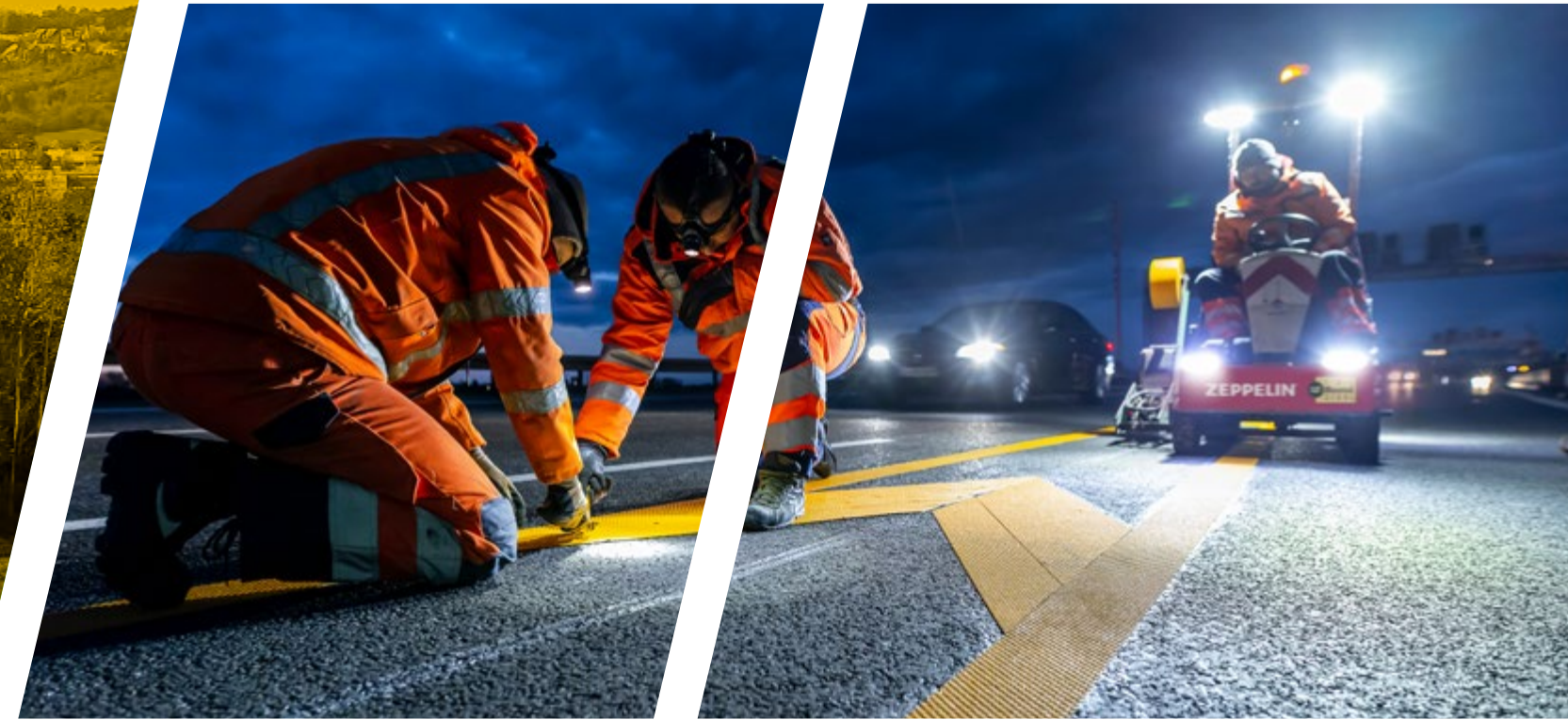
Fahrbahnmarkierungsarbeiten
