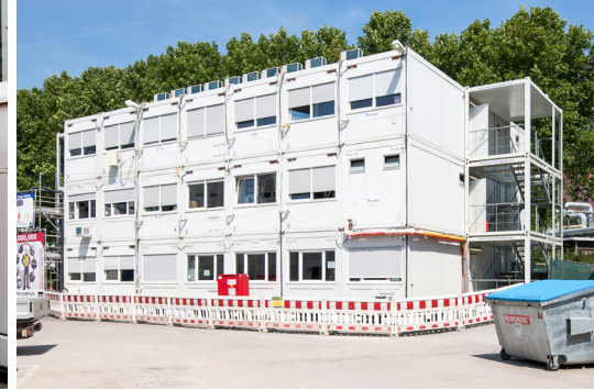
Bis zu 650 Container standen in Spitzenzeiten auf dem Baufeld.
