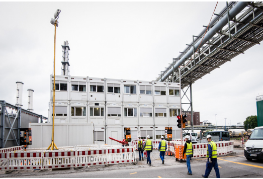
35 Baulogistiker vor Ort waren hier mit entsprechendem Equipment im Einsatz.
