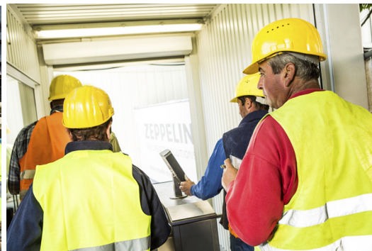
Zwei Drehsperren im Zutrittscontainer regeln den Zugang zu dem Bauvorhaben.
